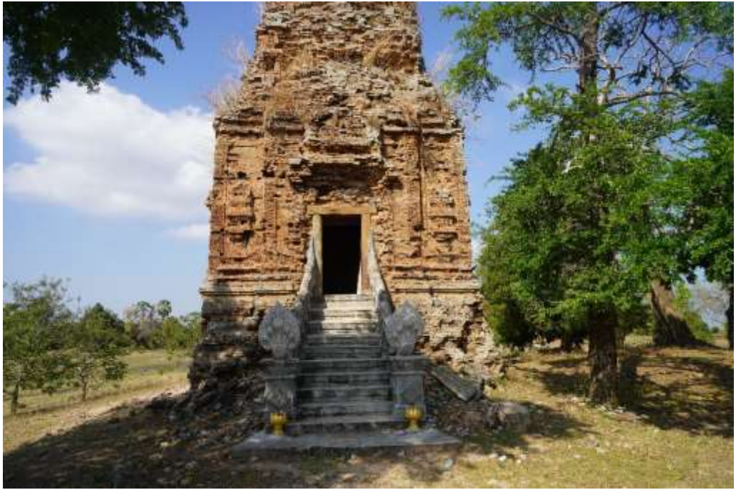
រូបលេខ៨៖ កាំជណ្តើរអ្នកស្រុកសាងសង់ពីស៊ីម៉ង់
